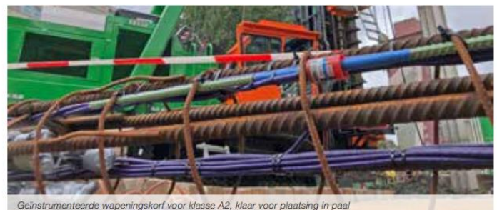
Geïnstumenteerde wapeningskorf voor klasse A2, klaar voor plaatsing in paal
